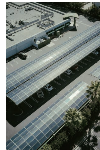
Estação de carregamento pública
